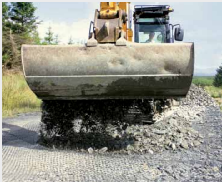
Строительство подъездных путей в Aresleach (Шотландия).
