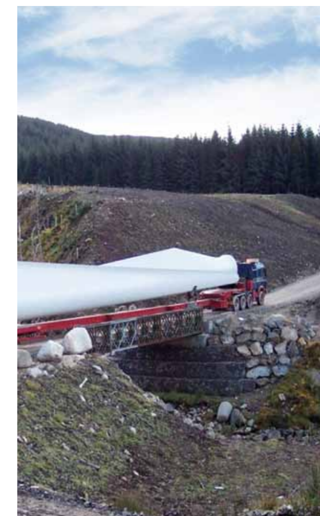
Системы TensarTech® Earth Retaining позволяют осуществлять быстрое строительство устоев мостов и подпорных стен.
