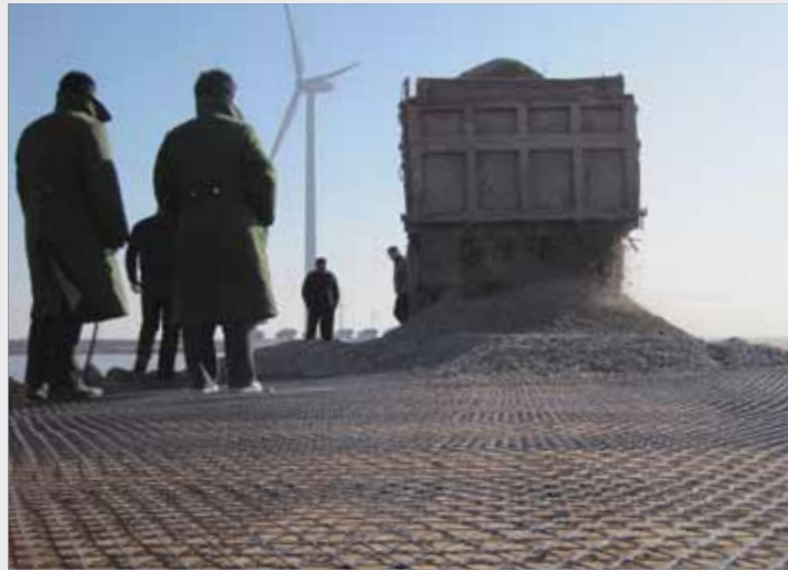
Георешетки TriAx® использованы для создания Механически Стабилизированного Слоя при строительстве подъездных путей к ветровой электростанции Dongying (Китай).
